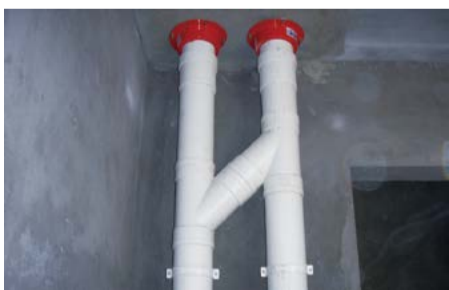
UPVC 管道阻火圈安装
