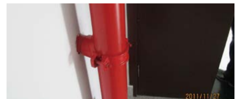
图30 配水干管与配水管机械三通连接
