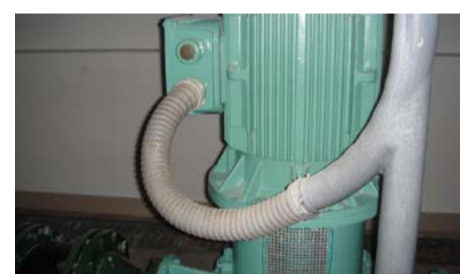
图28 可挠金属电线保护套管连接动力设备
