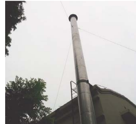
图24 风管室外立管的拉索设置
