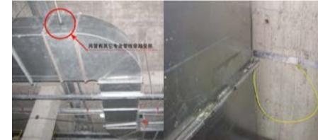
图22 风管内严禁其他管线穿越
