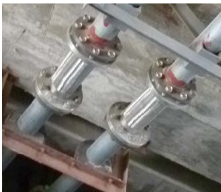
图3 管道穿越沉降缝采用软接头
