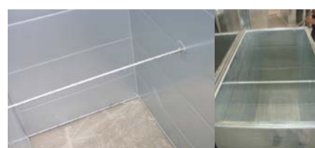
图20 风管内加固做法
