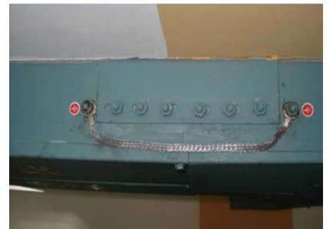
图27 接地跨接及标识
