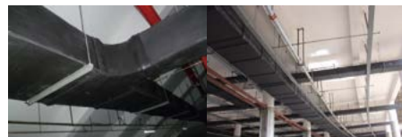
图25 绝热风管支架、支管安装
